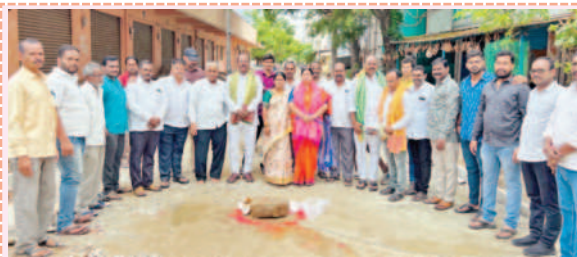
సిని రోడ్డు నిర్మాణానికి భూమి పూజ చేస్తున్న కార్పొరేటర్ పుష్పనగమ్
